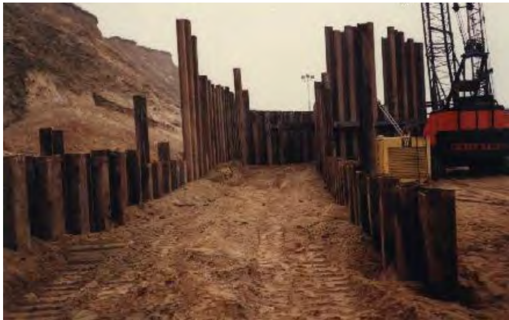
איור מס' 2-21: תמונות המציגות את הנחת הצינור ע"פ שיטת הסכר'
