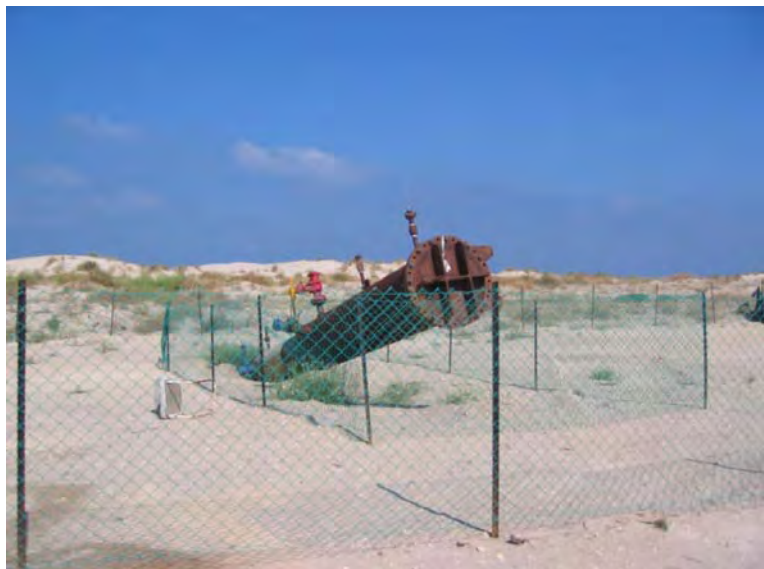
איור מס' 2-18: תמונות המציגות קידוח אופקי של צינור בקוטר 30" אתר דור
